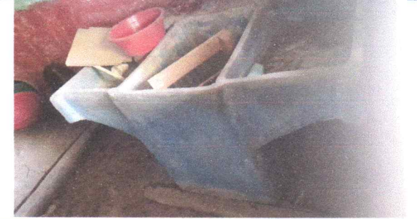
FOTO 10: Sustitución de pila de cemento de dos lavadero EN COCINA
