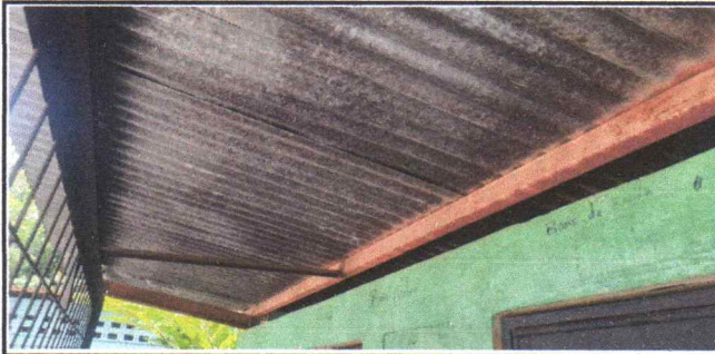
FOTO 1: Sustitución de lámina, por lámina troquelada aluzinc calibre 26 EN BAÑOS y mantenimiento a estructura de soporte de metal
