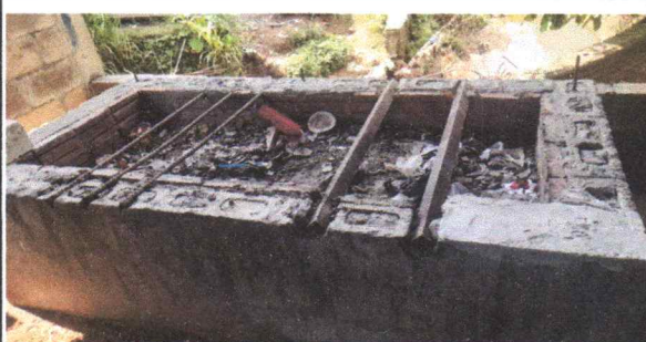
FOTO 9: Sustitución de estufa rural (completa) incluye chimenea y plancha de metal EN COCINA
