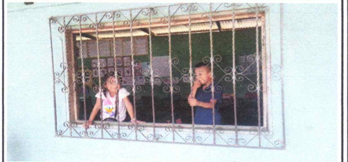
FOTO 14: Mantenimiento a balcones de metal EN AULAS
