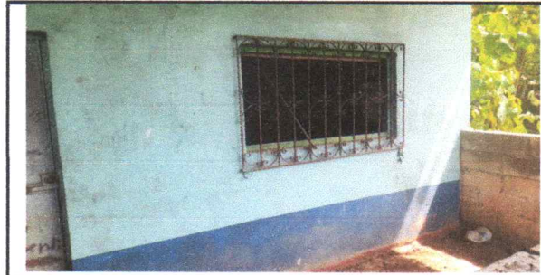
FOTO 6: Mantenimiento a balcones de metal
