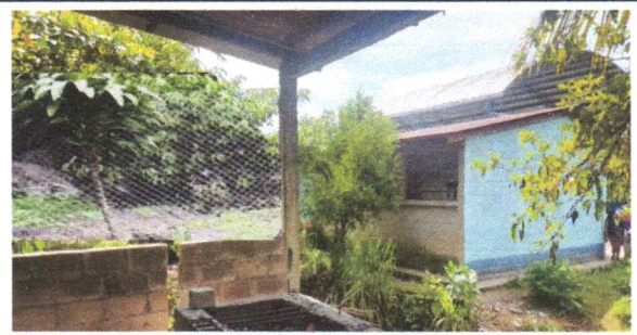
FOTO 8: Reparación de tubo hg y malla galvanizada
