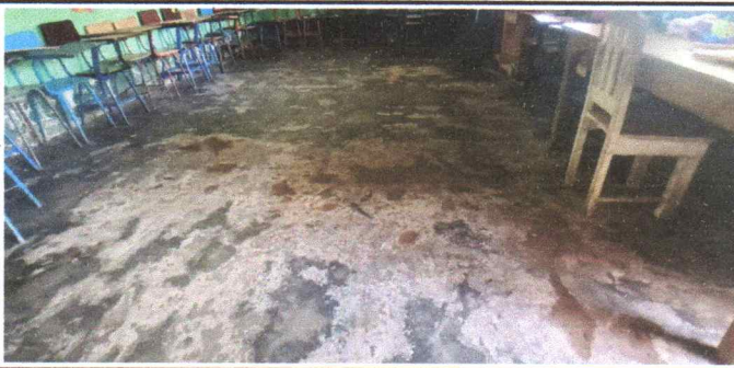
FOTO 15: Reparación de piso de cemento liquido
