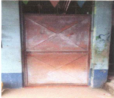
FOTO 13: Fabricación e instalación de metal en MODULOS
