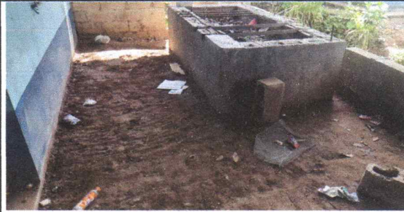
FOTO 7: Sustitución de piso de tierra por piso de torta de concreto EN COCINA
