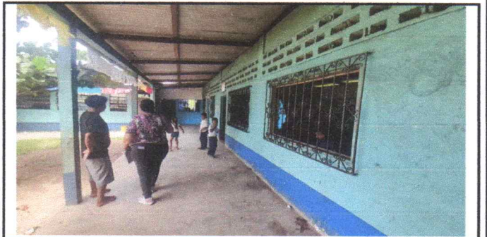
FOTO 16: Pintura en muros exteriores e interiores AULAS
