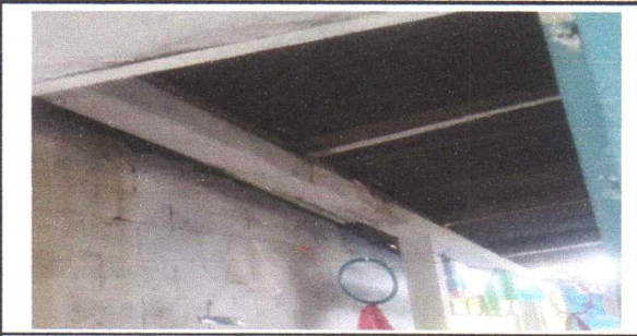
FOTO 11: Sustitución de lámina, por lámina troquelada aluzinc calibre 26 Y Sustitución de estructura de soporte de madera, por metal EN AULAS
